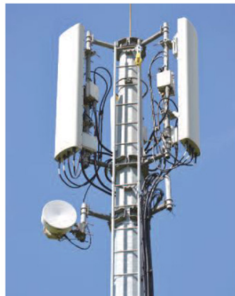
شکل ۵: پنل های آنتن پسیو چهار پورت، دو بانده (۱۸۰۰ و ۲۱۰۰ مگاهرتز) [۱۶]
